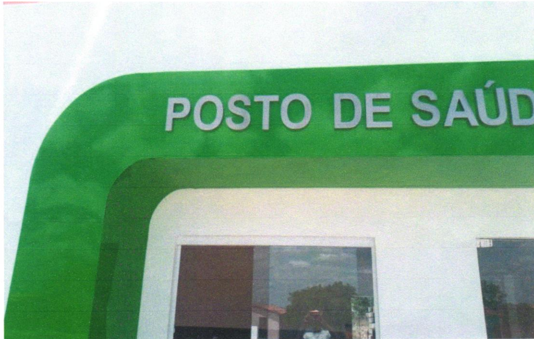
Foto 09- Letra em alumínio 20 x 20cm – instalado
