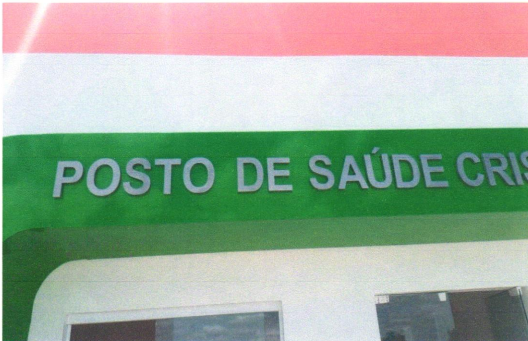
Foto 11 - Revestimento metálico em alumínio composto (Alucobond), e=0,3mm, pintura Kaynar 500 composta por seis camadas, inclusive estrutura metálica auxiliar em perfil de viga "U" de 2" - fornecimento e montagem
