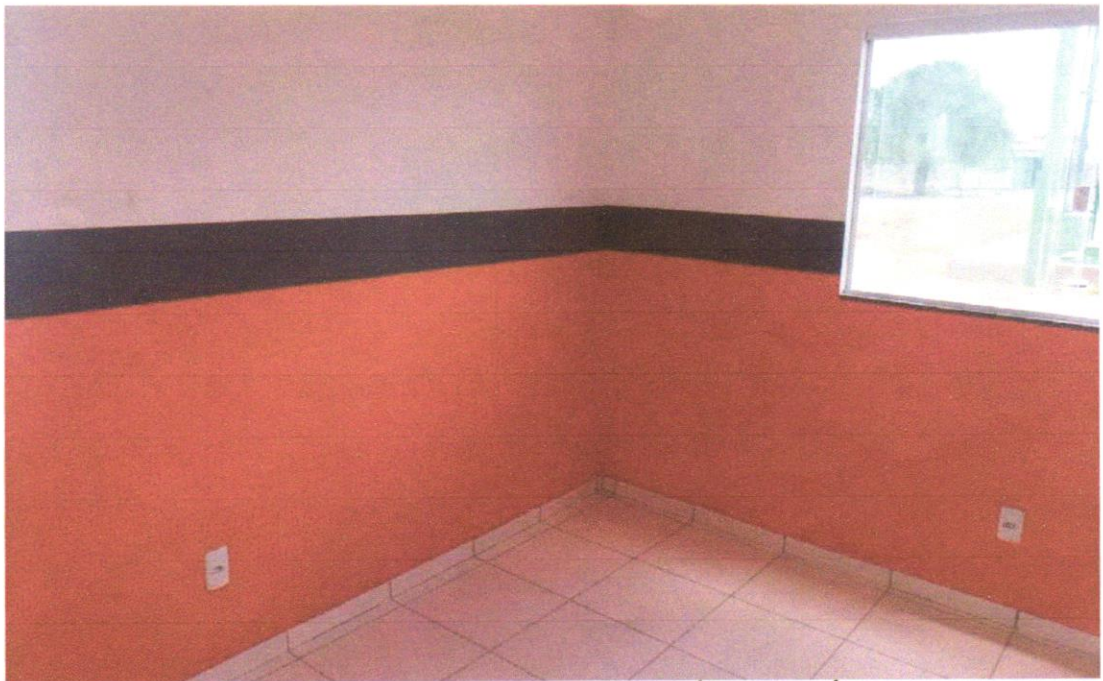
Foto 17 - APLICAÇÃO MANUAL DE PINTURA COM TINTA LÁTEX ACRÍLICA EM PAREDES, DUAS DEMÃOS. AF_06/2014
