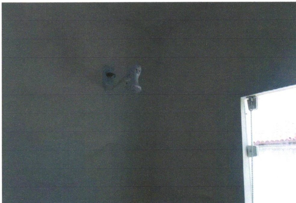
Foto 08 - CHUVEIRO ELÉTRICO COMUM CORPO PLÁSTICO, TIPO DUCHA □ FORNECIMENTO E INSTALAÇÃO. AF_01/2020
